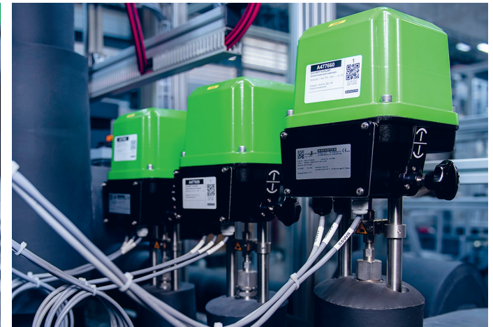
Das präzise Gleitschieber-Flansch-Motorventil 8038 von Schubert & Salzer erfüllt die anspruchsvollen Anforderungen.
