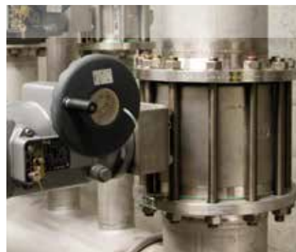
Elektrisch geregelte Kugelsektorventile von Bachofen in der Löschwasser-Verteilstation
