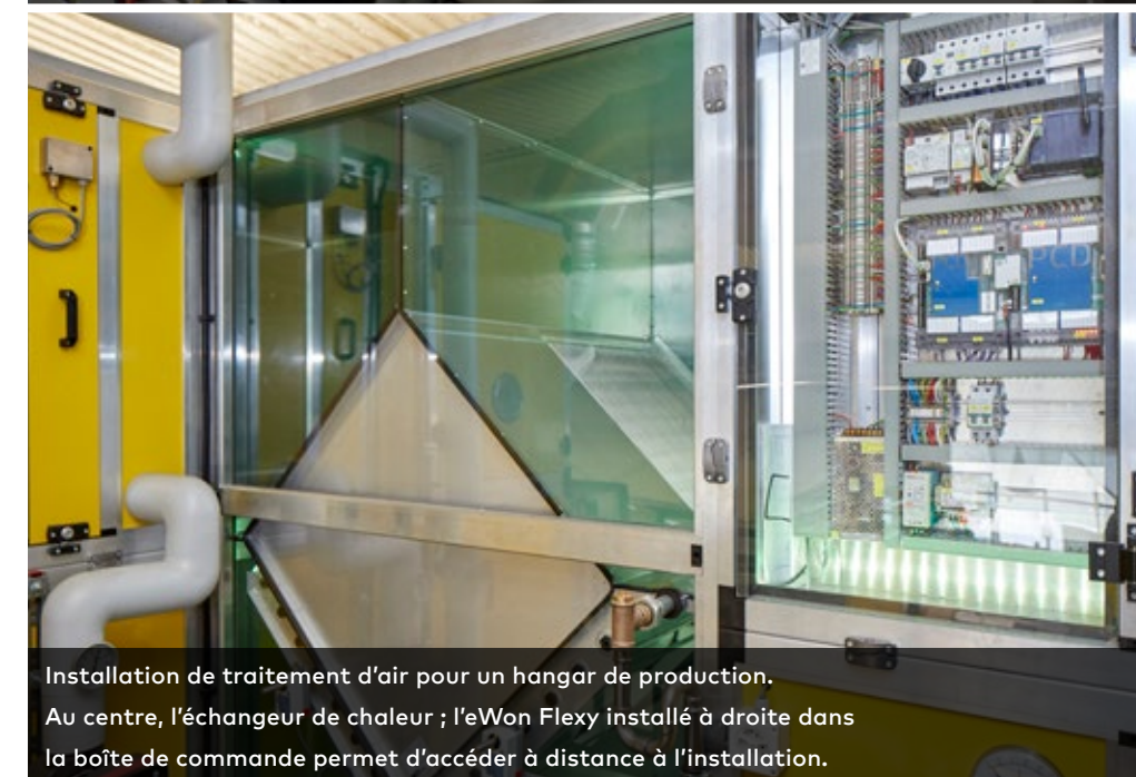
LeWon Flexy, reconnaissable à son antenne, intégré à la commande.
