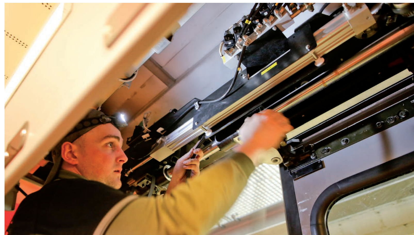
Montage en hauteur des cylindres d'entraînement et des blocs de soupapes fournis par Bachofen pour l'ouverture et la fermeture des portes
