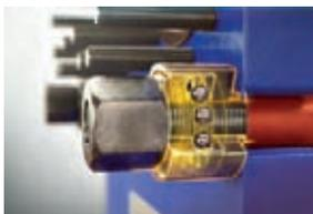
**Rollenlager** – erleichtert das Öffnen und Schließen des Wärmeübertragers – reduziert die Wartungszeit und erhöht die Sicherheit des Personals.
